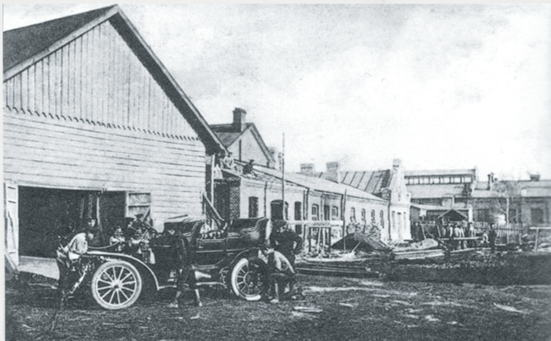
Барановичи, депо железнодорожной бригады
